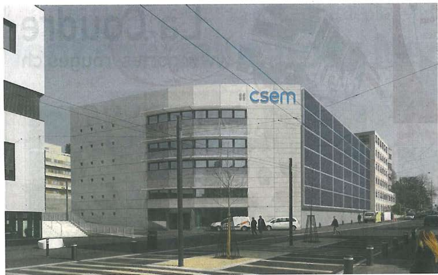
Composé de 210 panneaux, le mur solaire conçu par le bureau Geninasca-Delefortie sera installé au printemps 2015. SP-GDARCHILCH
