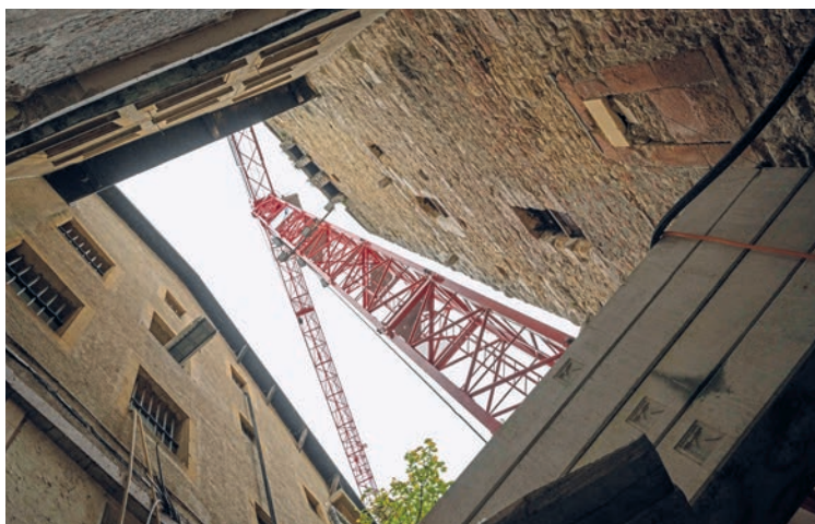
Une grue a pris place dans la cour intérieure, entre la tour médiévale et le corps des anciennes prisons.
