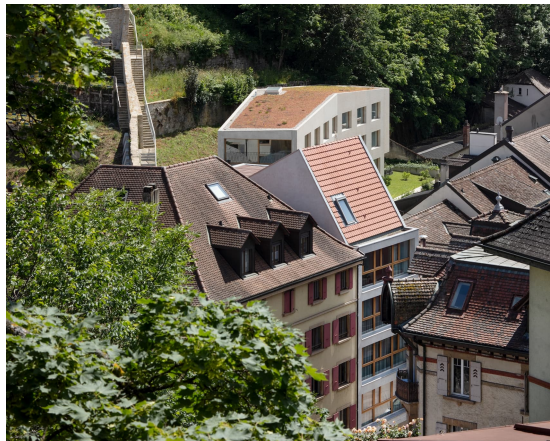
Les bâtiments de la rue de l'Ecluse ont été construits au pied du Château. Photo: Yves André
